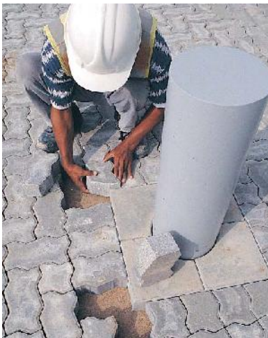
Hình 13. Các viên gạch được cắt khớp với xung quanh cổ bê tông ở các cột và các cấu trúc tiện ích.
