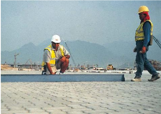
Hình 19 and 20. Kiểm tra dung sai cho phép của bề mặt bằng thước thẳng và kiểm tra độ phẳng mịn trên toàn bộ mặt đường nhằm đảm bảo mặt đường chịu được khi máy bay đổ lại trong suốt thời gian tiếp nhiên liệu
