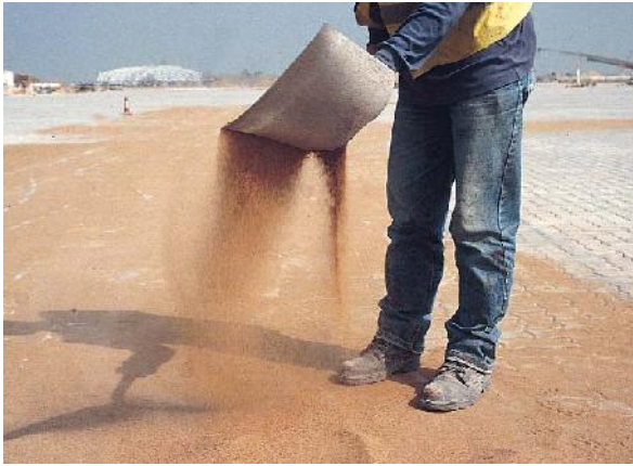
Hình 16 và 17. Cát chèn khe đã sấy khô được rải trên các lớp gạch đã được lu lèn và được lu lèn vào các khe cho đến khi nào các khe đầy cát. Cấp độ phân loại của cát chèn khe tốt hơn cát đệm.
