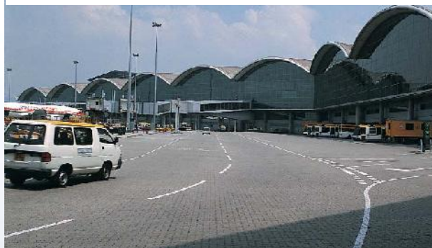
Hình 2. Các mặt đường gạch bê tông tự chèn được lựa chọn bởi chúng chịu được độ lún xung quanh nhà ga sân bay và có khả năng phục vụ tốt cho sân bay.
