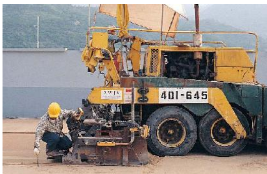
Hình 7. Máy rải nhựa asphalt được điều khiển chính xác bằng sóng âm được sử dụng, lớp cát đệm dày \frac{3}{4} in. (20 mm) được rải lên bề mặt phẳng mịn của CTB
