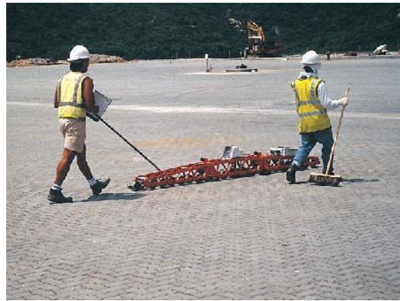
Hình 19 and 20. Kiểm tra dung sai cho phép của bề mặt bằng thước thẳng và kiểm tra độ phẳng mịn trên toàn bộ mặt đường nhằm đảm bảo mặt đường chịu được khi máy bay đổ lại trong suốt thời gian tiếp nhiên liệu
