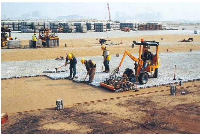
Hình 10. Việc cơ giới hóa công tác lắp đặt đã đẩy nhanh quá trình thấm bằng việc sử dụng 3 máy thấm để lắp đặt các lớp thấm theo mô hình xương cá cuối cùng. Lưu ý các kiện gạch thấm ở xung quanh và nhóm công nhân đang canh chỉnh các hàng khe và nối chặt giữa mỗi lớp thấm với lớp bên cạnh.
