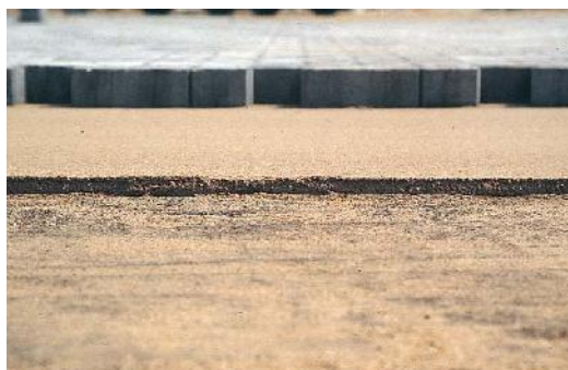
Hình 8. Lớp cát được sang phẳng đã được duy trì ở độ dày đồng nhất nhờ bề mặt của CTB nằm trong phạm vi dung sai về độ phẳng mịn.
