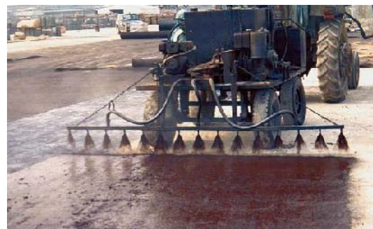
Hình 6. Lớp tráng nhựa bitumen giữ cho lớp vải địa kỹ thuật nằm ở vị trí phía trên CTB. Sau đó lớp cát móng được rải lên để giữ vật liệu bitumen không bị dính vào ứng và lớp xe.
