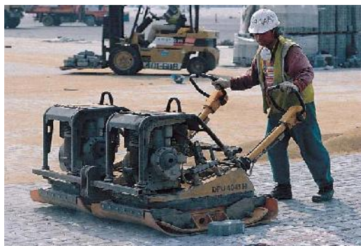
Hình 15. Máy đầm bàn nặng 9,000 lbf (40 kN) được sử dụng để lu lèn các viên gạch thấm vào lớp cát đệm, sau đó một lần nữa lu lèn cát ở các khe. Hai lần được kết hợp lại sẽ đầm lại hiệu quả cao hơn.
