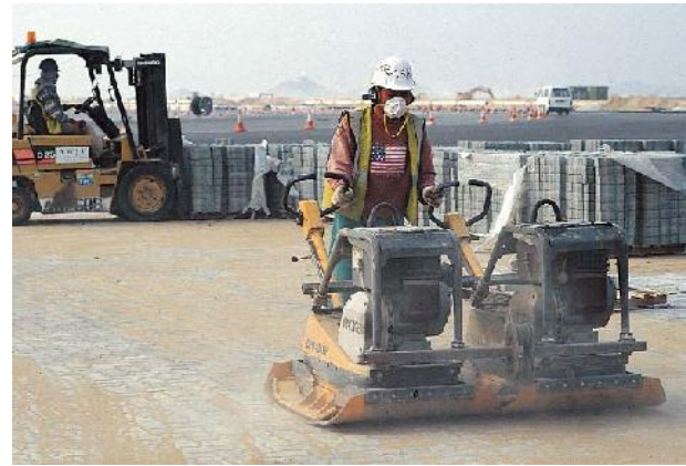
Hình 16 và 17. Cát chèn khe đã sấy khô được rải trên các lớp gạch đã được lu lèn và được lu lèn vào các khe cho đến khi nào các khe đầy cát. Cấp độ phân loại của cát chèn khe tốt hơn cát đệm.
